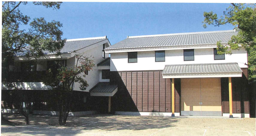
新築された備品倉庫と職員寮
