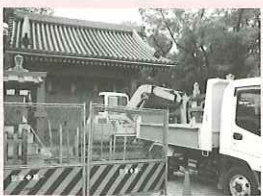
復旧作業中の鳥居
