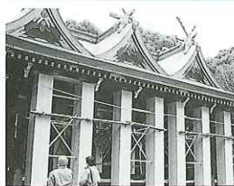
二月六日 本殿・拝殿補強工事及び復旧工事調査開始 諸社社復遷座 南門復旧工事着工
