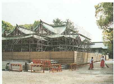
▲① 足場が組み立てられ、化粧直しの進む拝殿。
