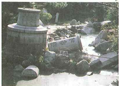
▲⑨ ほとんどの石造物、あずまや等が崩壊、底も抜け水も流失、本格的な改修が必要な神池。
