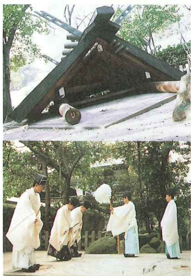
▲⑧ 屋根が落下した葎所、屋根を撤去し仮復旧。
