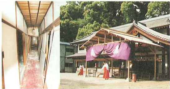
▲③ 震災当時の社務所内部。④現在の仮社務所・仮本殿となっている神輿殿。
